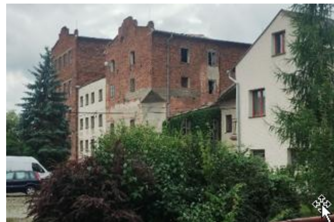
Mlýn z konce 15. století, přestavěn v 18. i 20. století, dnes MVE, obnoven historický rybník v dnešní zahradě severně od mlýna. Areál nerozšiřovat o stavby bez historického kontextu a s ohledem blízkost PP Malá voda
