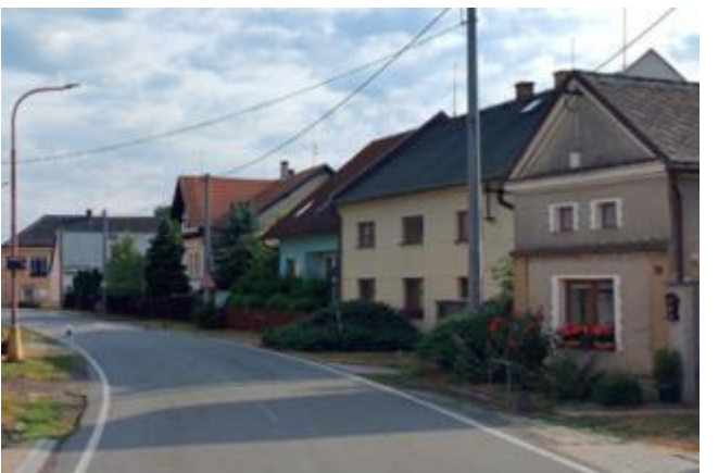
Dochovaná urbanistická sturktura starší část obce (1-2 podlažní objekty, sedlové střechy, štítové a opakové uspořádání uliční zástavby, předzahrádky bez oplocení)
