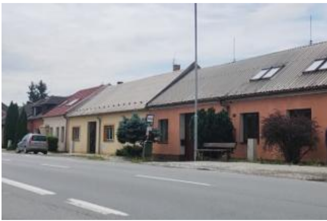
Předválečná zástavba Chomoutova tvoří suvislou uliční frontu nízkopodlažních objektů se sedlovou střechou
