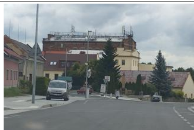
Vodní elektrárna uvedená do provozu r. 1911, pohled z nám. Osvobození
