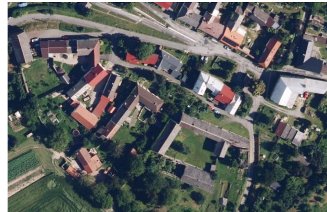
Patrné historicky dochované štítové i okapové uspořádání statků a ostatních usedlostí, v částech tvoří souvislou frontu. Charakteristické plochy zahrad a sadů na přechodu do volné krajiny
