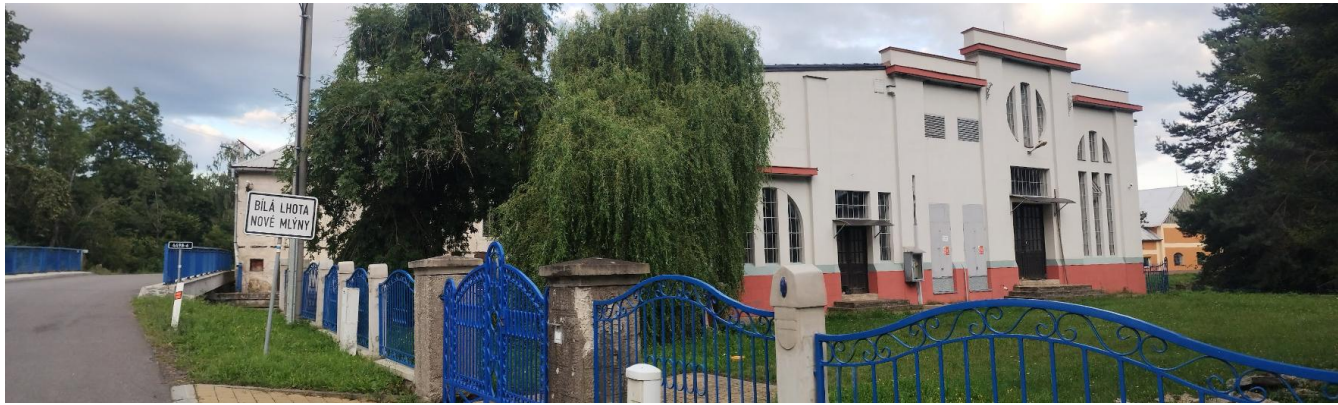
Areál funkcionalistického mlýna na okraji enklávy Nových Mlýnů, areál uzavřen, část ve zhoršeném stavebním stavu, v zadní části patrný nový objekt, součástí poloha nivních luk, areál oplocen
