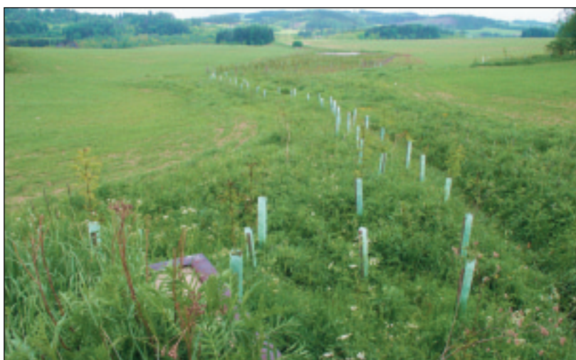
Obr. 11: Lučinka-Hájek sever. Realizace protierozních opatření a tvorby ÚSES na rozlehlých zemědělských plochách v katastru obce Dolní Moravice. Zabránění vodní eroze pomocí úpravy koryta, výsadby břehových porostů a vybudováním dvou bezodtokých poldrů.
